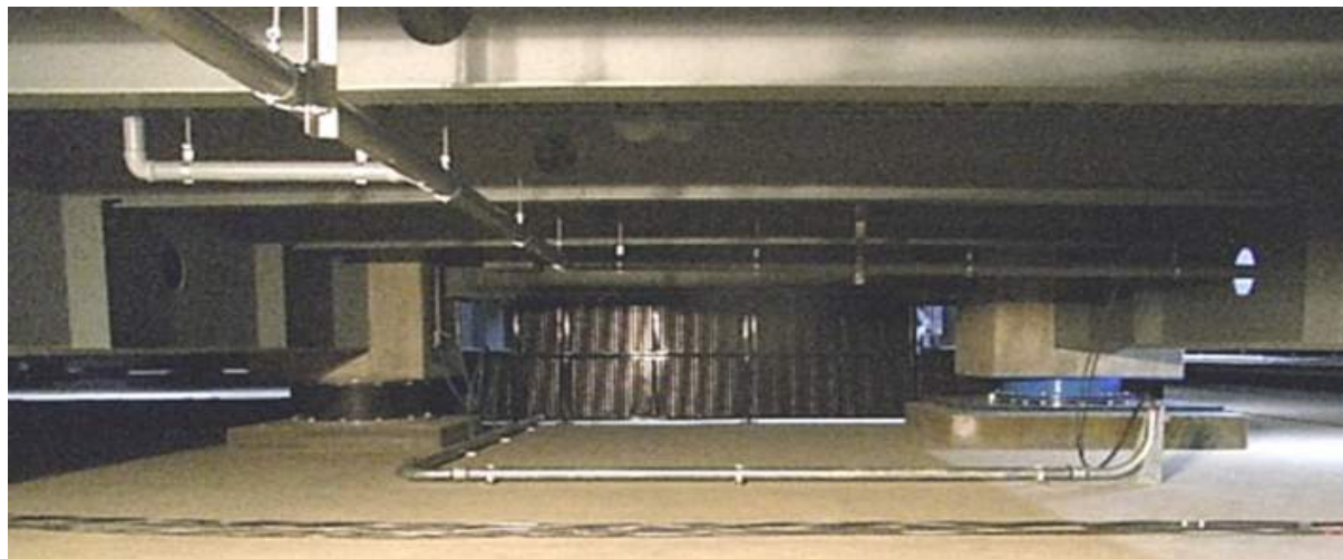
【B1の免震構造(ハイブリットTASS構法採用)】
